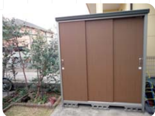
地面に固定していない
