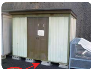
地面に固定している
