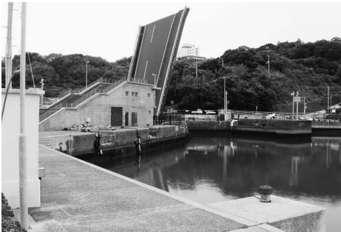
手結港可動橋の地震対策は
