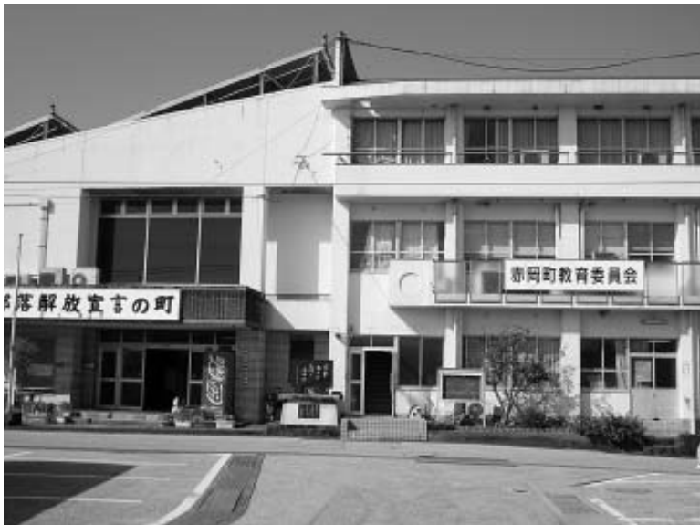
改築予定の赤岡市民館
