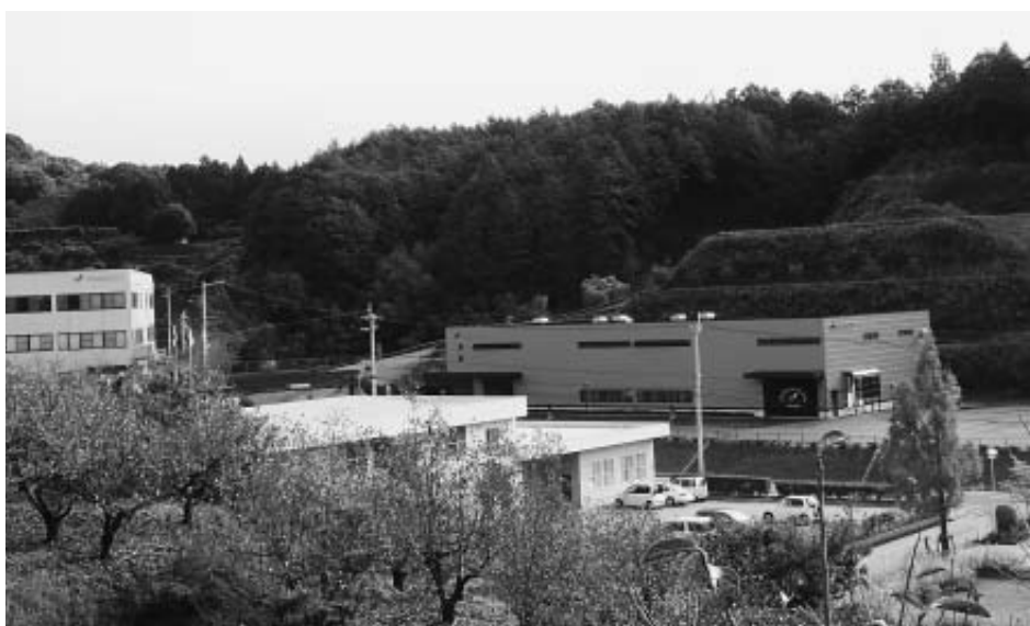
大谷工業団地に接する工業団地予定地
