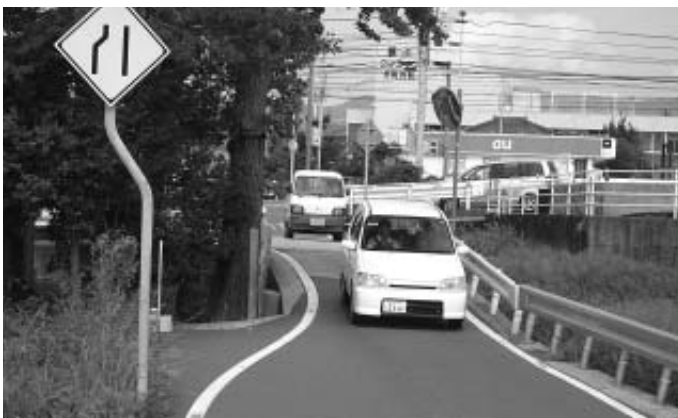
県道野市遠崎線の狭隘部分
