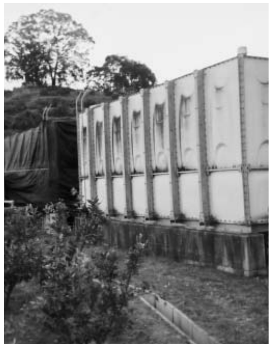
パイプラインの取水施設
