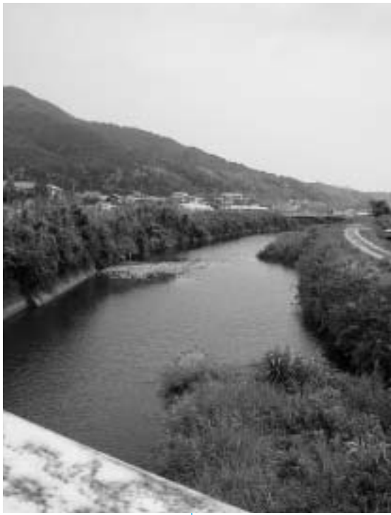
早期の改修が望まれる夜須川
