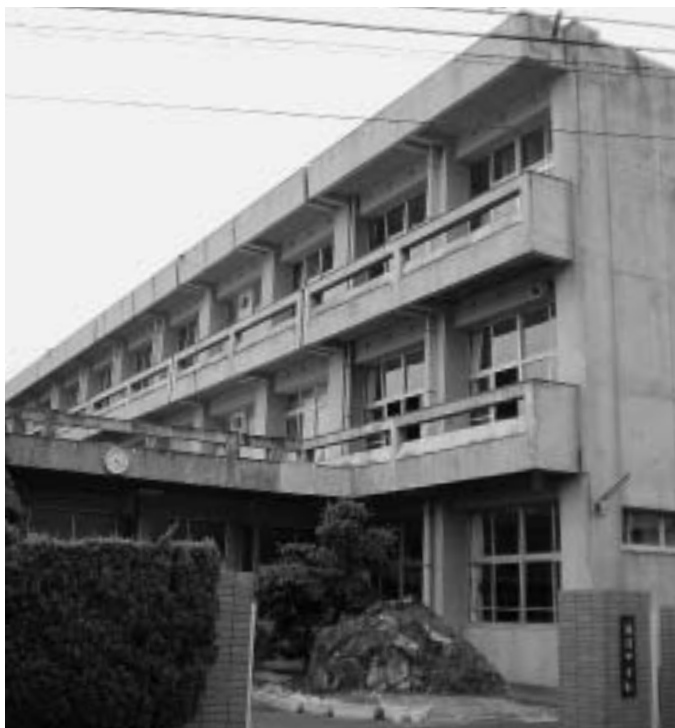
耐震補強工事が求められる夜須中学校
