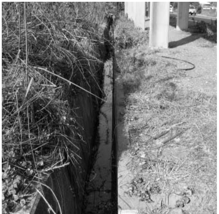
整備が進む排水路
