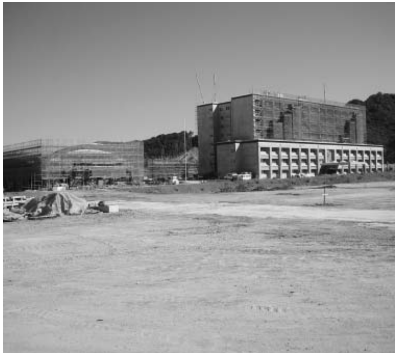
整備が進む駐屯地
