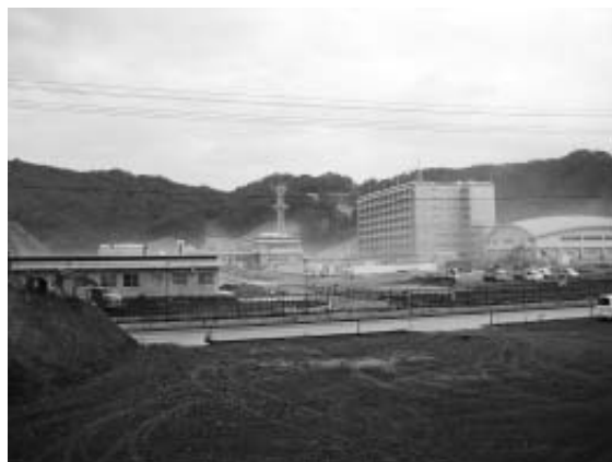
完成間近な駐屯地
