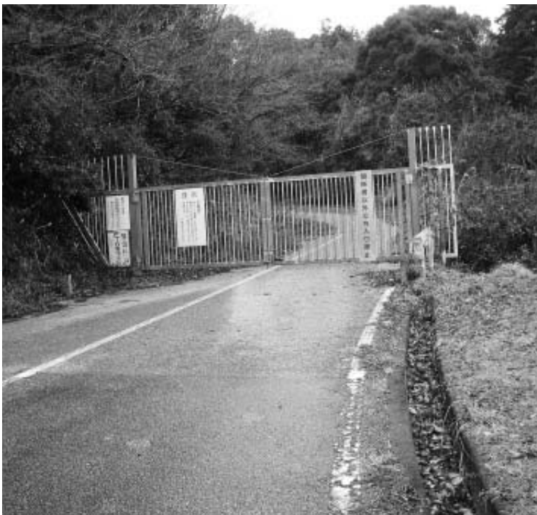
閉鎖になっている進入路
