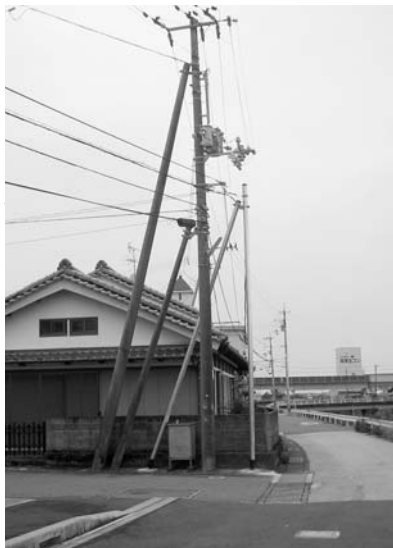
電柱脇に新設された自営柱
