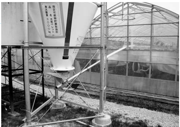
木質ペレットタンク
