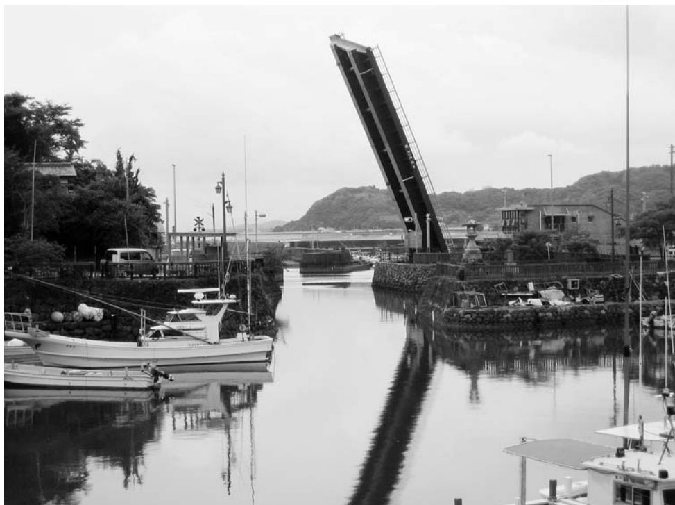
手結内港から望む可動橋
