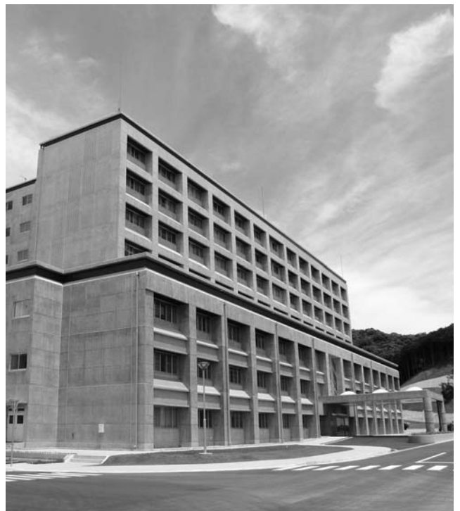
姿を現した高知駐屯地庁舎
