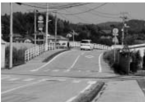
危険な歩道移動箇所・香我美町下分
