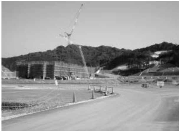
急ピッチで建設の進む庁隊舎
