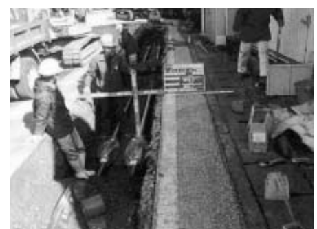
水道管の布設替え工事
