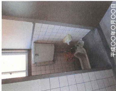
①-1 トイレ改修 (手すり)
