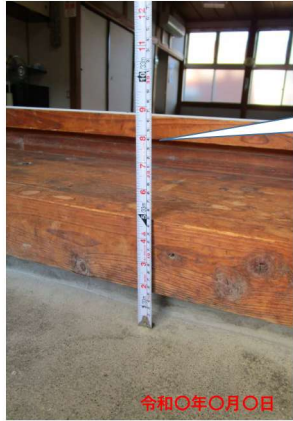
②-3 上がり框改修（手すり）
