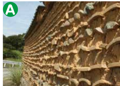
A 白い漆喰壁の横に瓦で積み上げられた 赤土の塀。芸術ともいえるこの壁に、道 行く人の目が釘付けになります。
