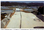
災害時の緊急輸送路としても機能する「東海自動車道」(平成20年代半ば竣工)
