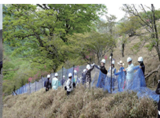
▲防鹿柵の拡張設置
