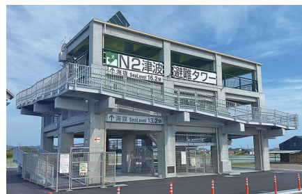
N 2 野市町八丁地津波避難タワー
