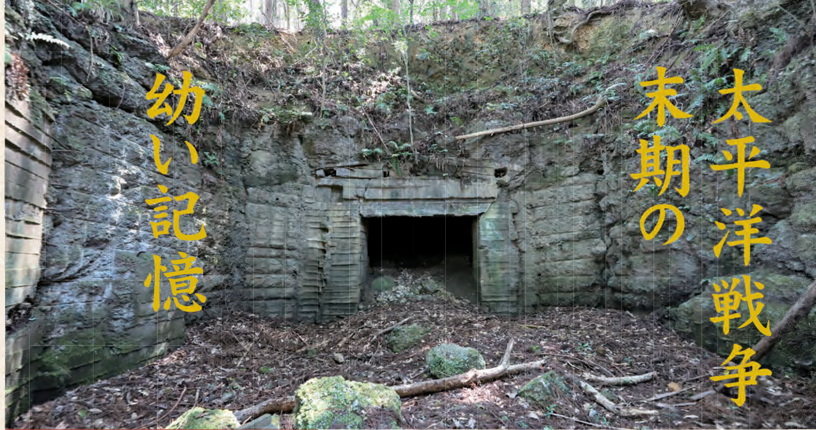
▲千切砲台跡：本土決戦陣地としては県内最大級のコンクリート構造物 外から見えないよう、この中に大砲を据えた
