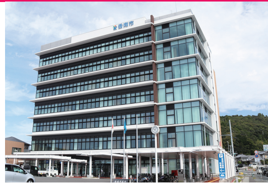
令和2年 新庁舎完成
