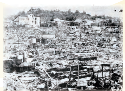
▲空襲から3日後の高知市廿代町 ※高知市立市民図書館所蔵 寺田正写真文庫
