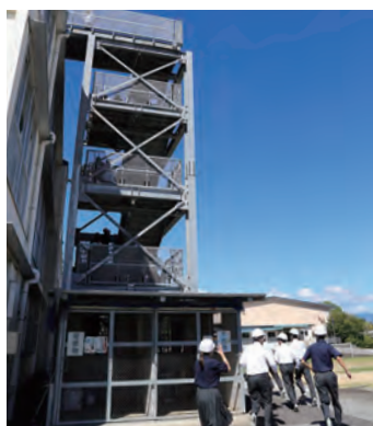
▲避難訓練では、避難用外階段を使って屋上へ
