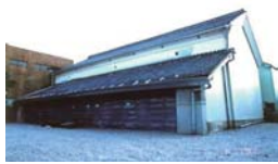
▲改築前の米蔵の写真
