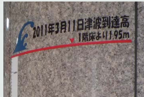
▲津波の到達高の標示。床より1.95mと書かれていますが、実は海拔16mの丘にある建物での数値なのです
