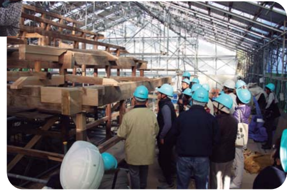
▲すべて分解された後、組み上げ直された柱を見上げる
