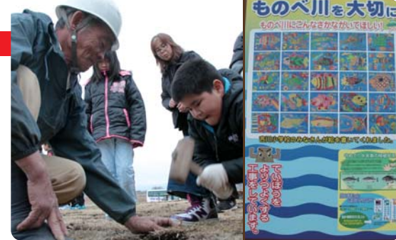
▲物部川河川敷の工事現場で芝張り体験 看板は吉川漁協の西側にある展望台に設置された▲
