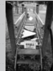
ヤ・シィパークのこども広場では、潮風の影響で11の遊具などが腐食・破損し使用できない状態になっている。
