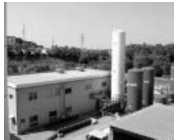
▲ガスプラント外観(香我美町)
