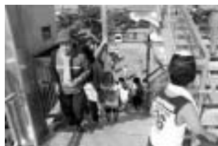
▲完成した避難階段を使って
