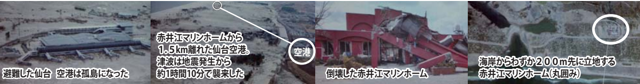
避難した仙台 空港は孤島になった
