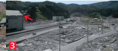
3 震災後、がれきの撤去をした生涯教育センター(矢印)付近。住宅は流され電柱が寂しく建っています。
