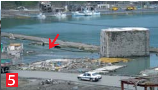
5 海岸の岸壁では、地盤沈下(矢印)により、現在も満潮時には浸水している。
