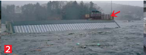
2 生涯教育センターは高さ約20mの4階建てで、建物が全て水没するくらいの津波の高さになりました。ここにいた職員は、屋上(矢印)に逃げてなんとか助かりました。
