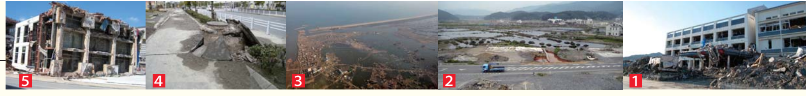
1 災害復旧拠点を襲った津波 (岩手県陸前高田市役所) 2 標高の低い平野部で浸水が続いている (陸前高田市中部・9/13撮影) 3 直線的海岸を襲った津波 (宮城県仙台市閉上3月13日11:52撮影) 4 液状化による二次被害、約70cm下水道管が隆起 (千葉県浦安市) 5 今まで強い構造物だと思われていた鉄筋コンクリート造りの基礎杭が、おそらく液状化によって抜けてしまい、その後津波によって横倒しになった。(宮城県女川町)
