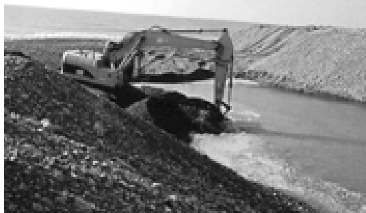
アユが川をのぼれるように河口の土砂を取り除く
