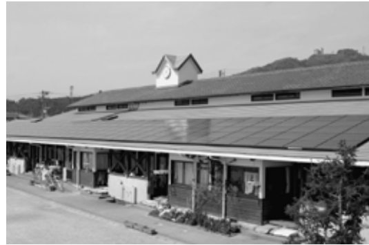
▲19年度に設置された野市東幼稚園のソーラーパネル
