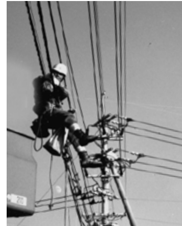
ケーブルの張り替え作業
