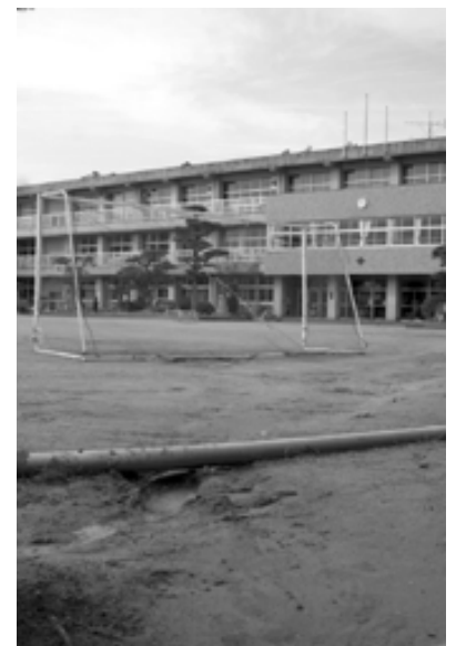
排水パイプがむき出しになっている夜須小学校グラウンド
