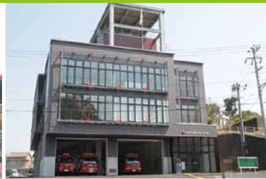
平成24年 消防庁舎完成
