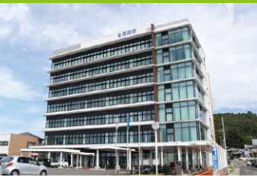
令和2年 新庁舎完成
