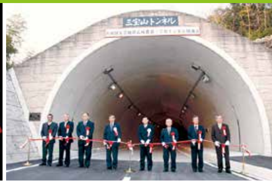
平成18年 三宝山トンネル開通
