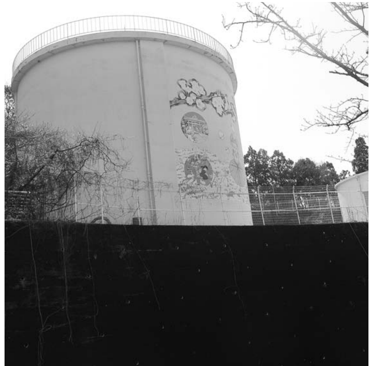
市民の暮らしを守る配水池
