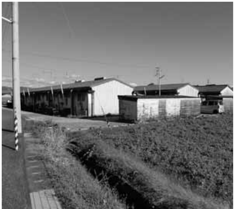
老朽化した市営住宅
