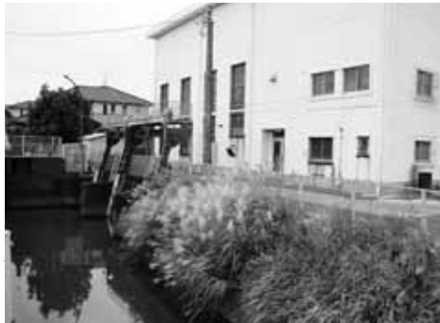
岸本にある西部排水機場
