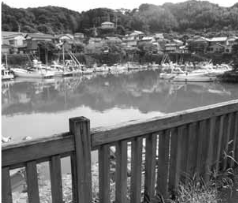
年度内に浚渫予定の手結内港
