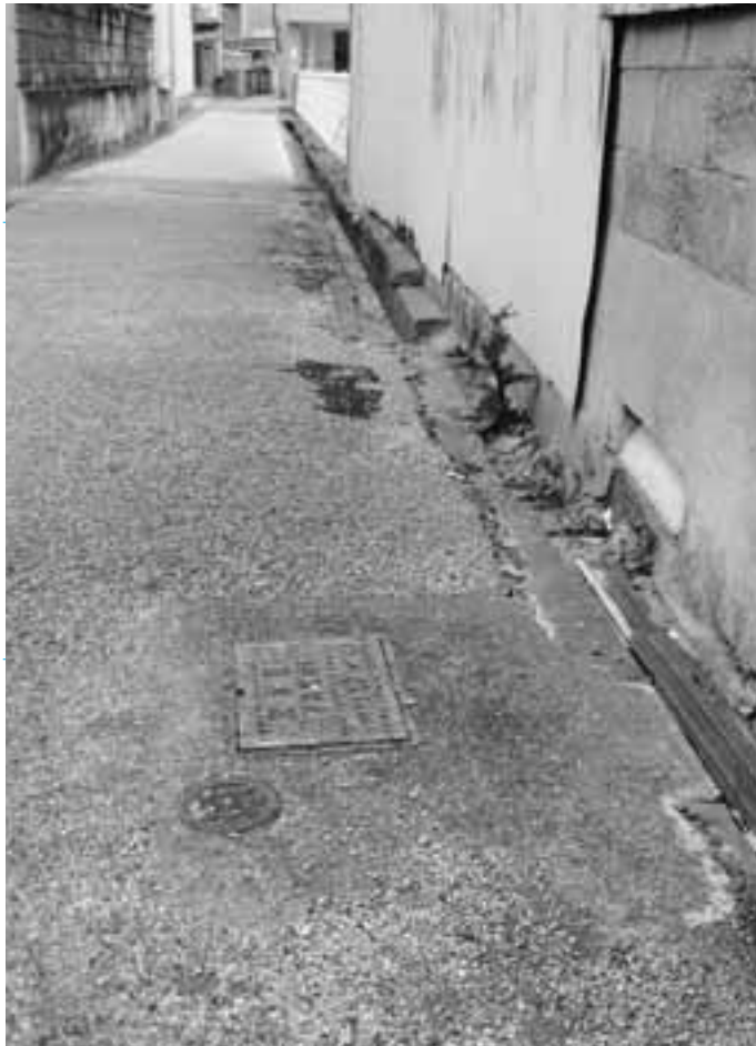
市道に設置されている水道メーター
