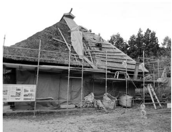
かやぶき葺き替え作業中
