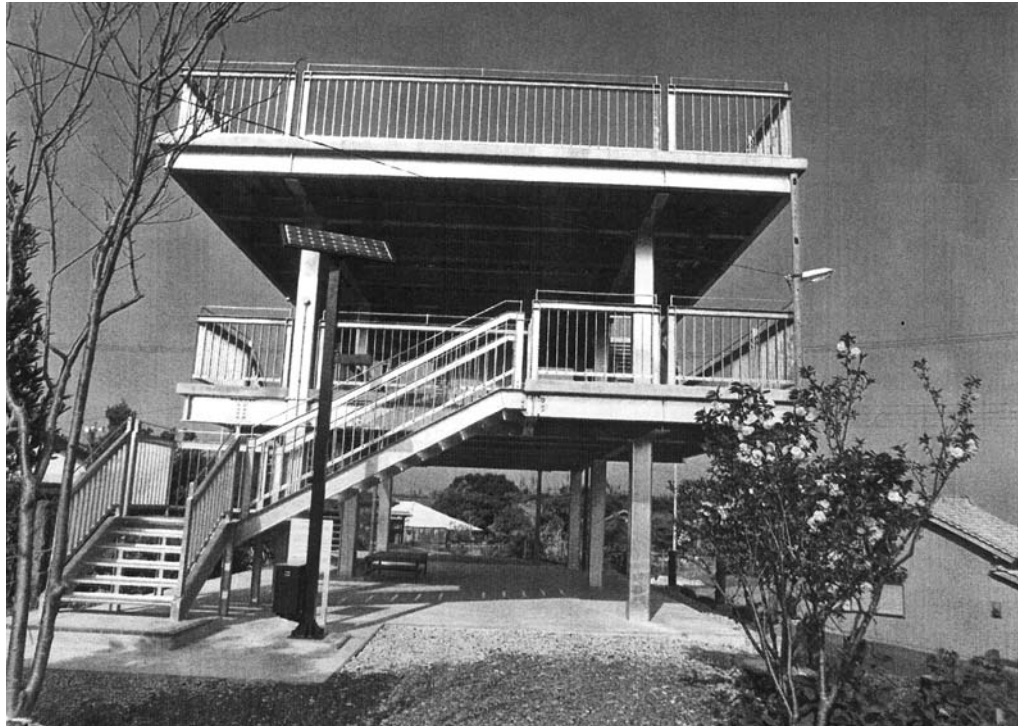
津波避難タワー
