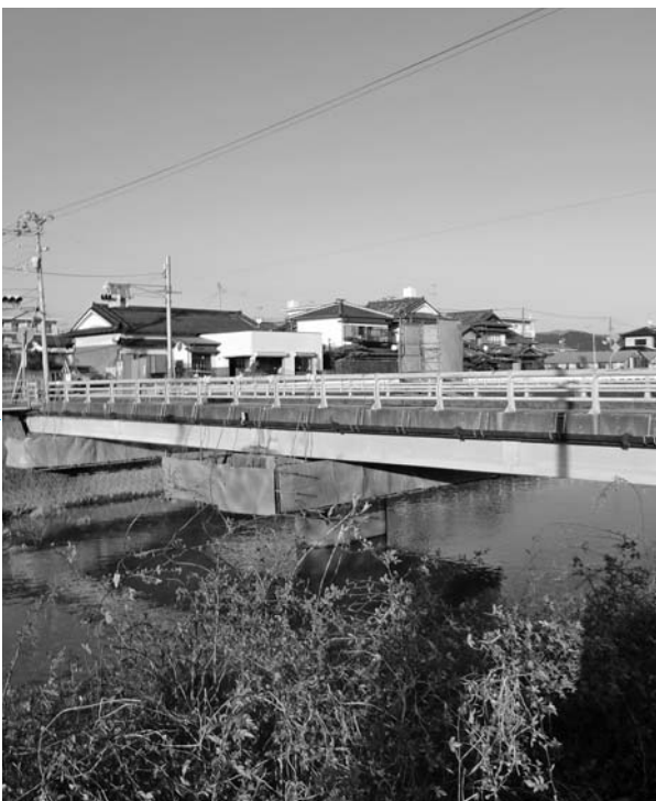
耐震工事(赤岡町大忍橋)
