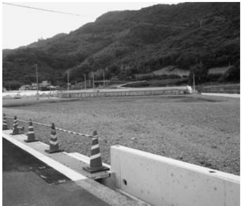
給食センター建設地
