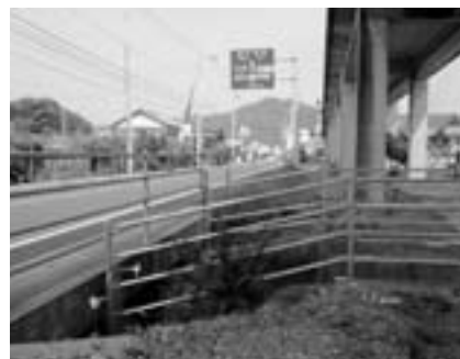
危険箇所に設置されたガードパイプ
