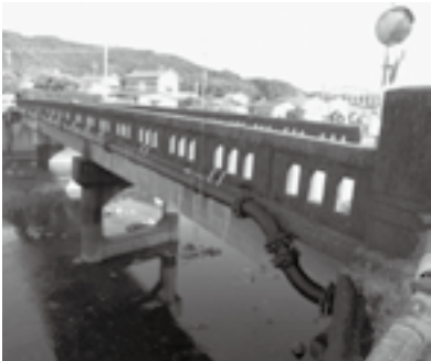
豊栄橋の耐震工事は
