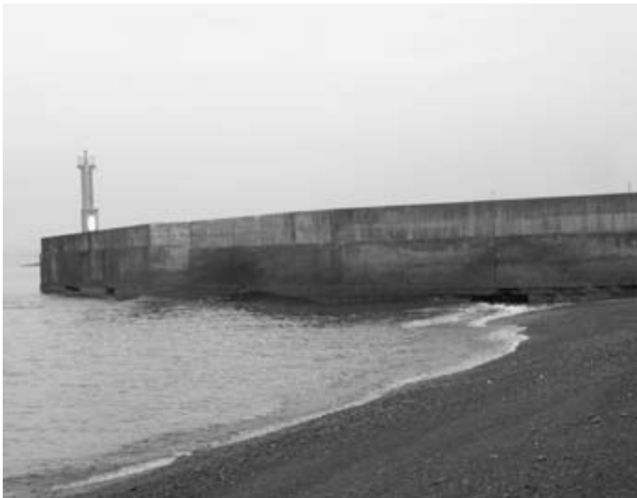
防波堤の修理を
