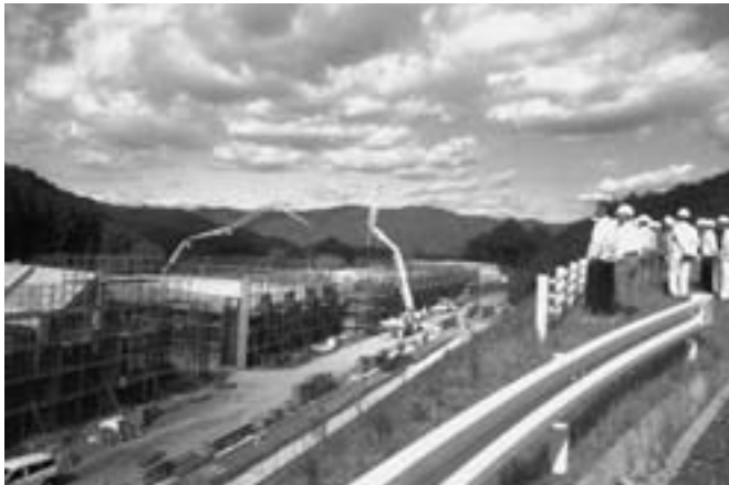
建設が進む自衛隊覆道射撃場
