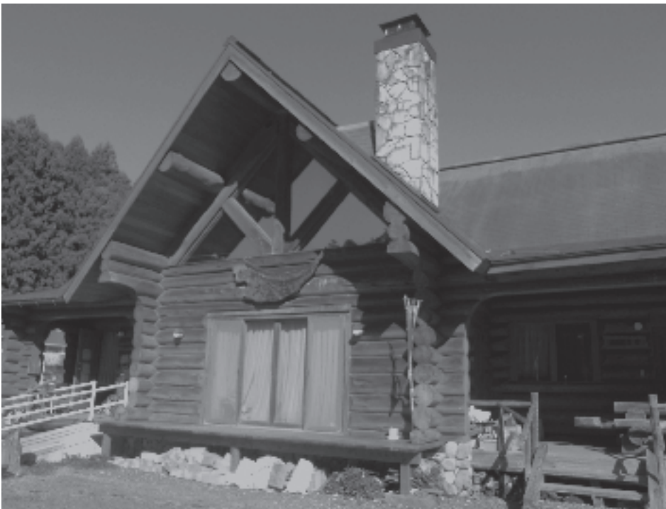
火災のあった羽尾林業活動活性化センター
