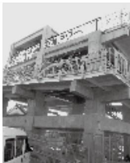
吉川町西南津波避難タワー
