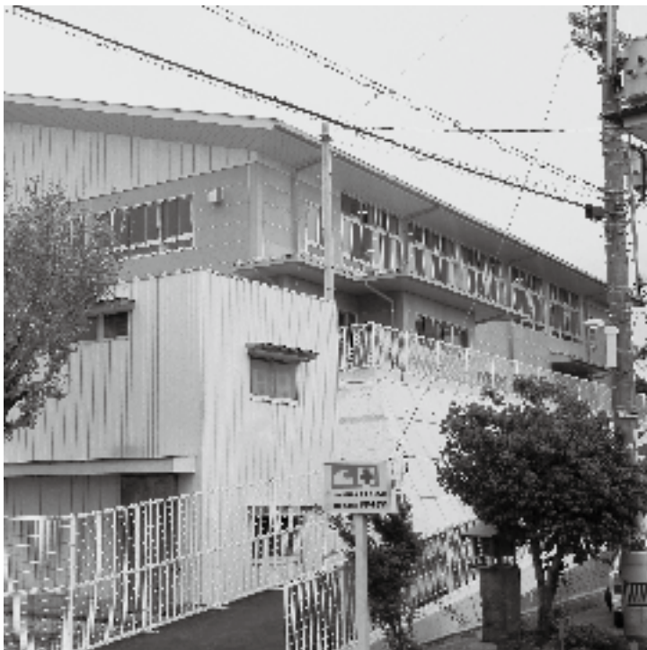
赤岡小学校屋内運動場
