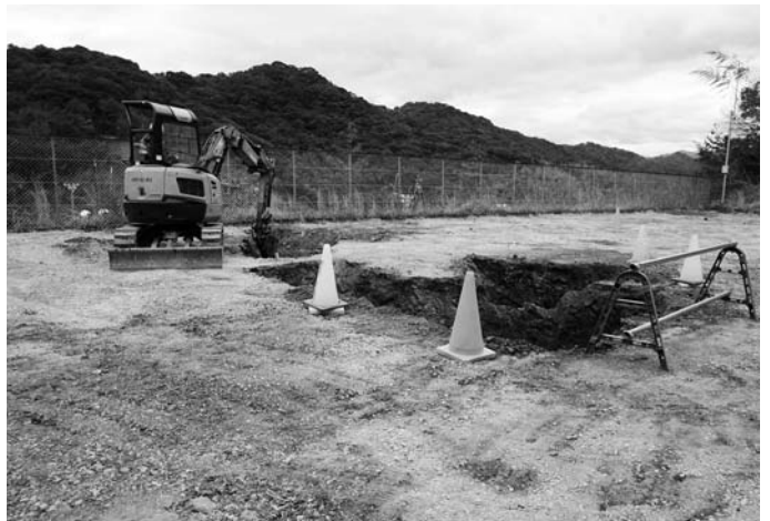
夜須新配水池設置工事現場
