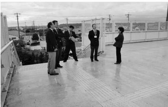
(歩道橋兼津波避難タワー)
