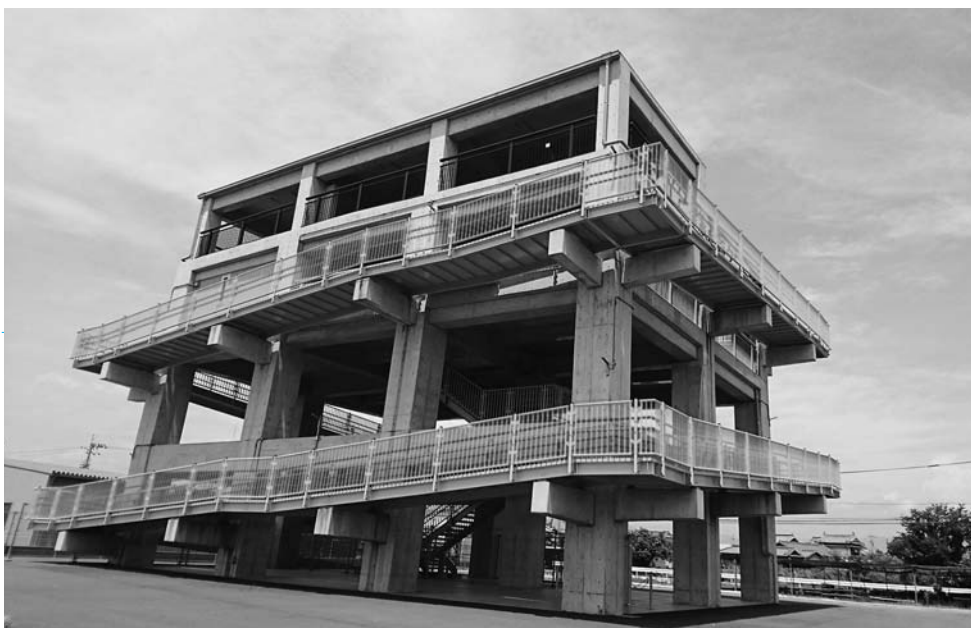
津波避難タワー
