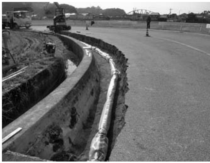
耐震管への布設替工事
