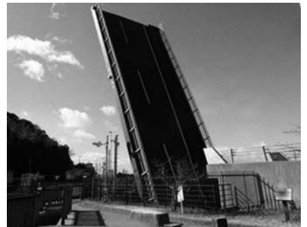
手結港可動橋
