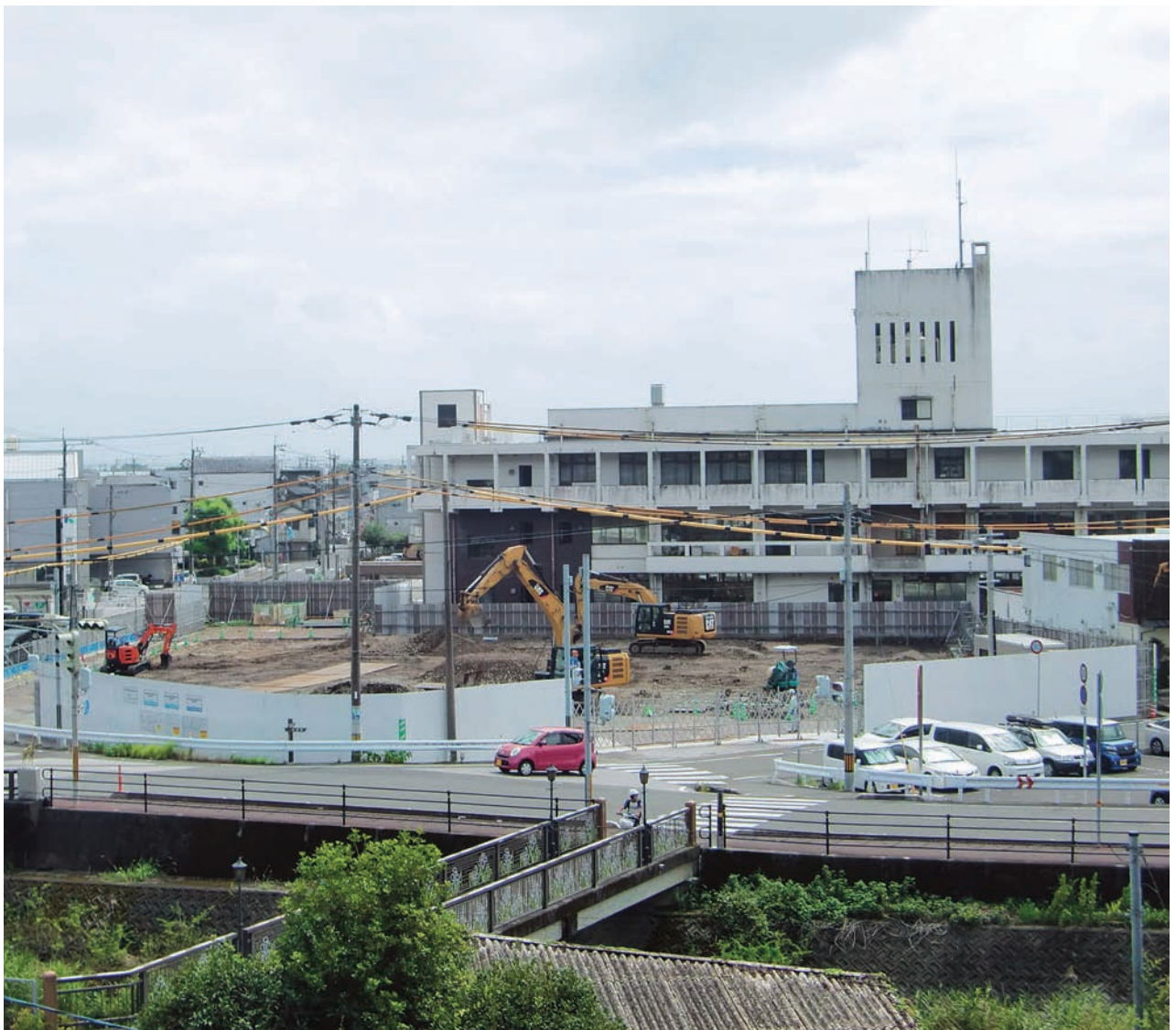
新庁舎建設工事
