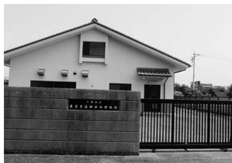
上岡地区農業集落排水処理施設
