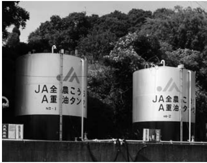
重油タンク（夜須町坪井）
