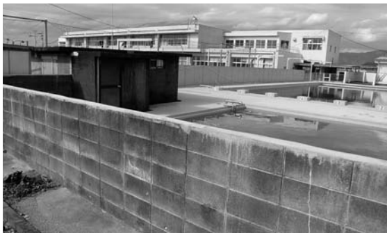
改修済みブロック塀(岸本小学校)
