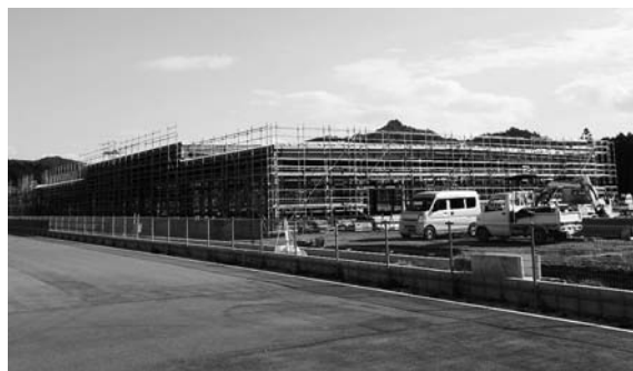
香南工業団地 みすまる加工(株)工場建設
