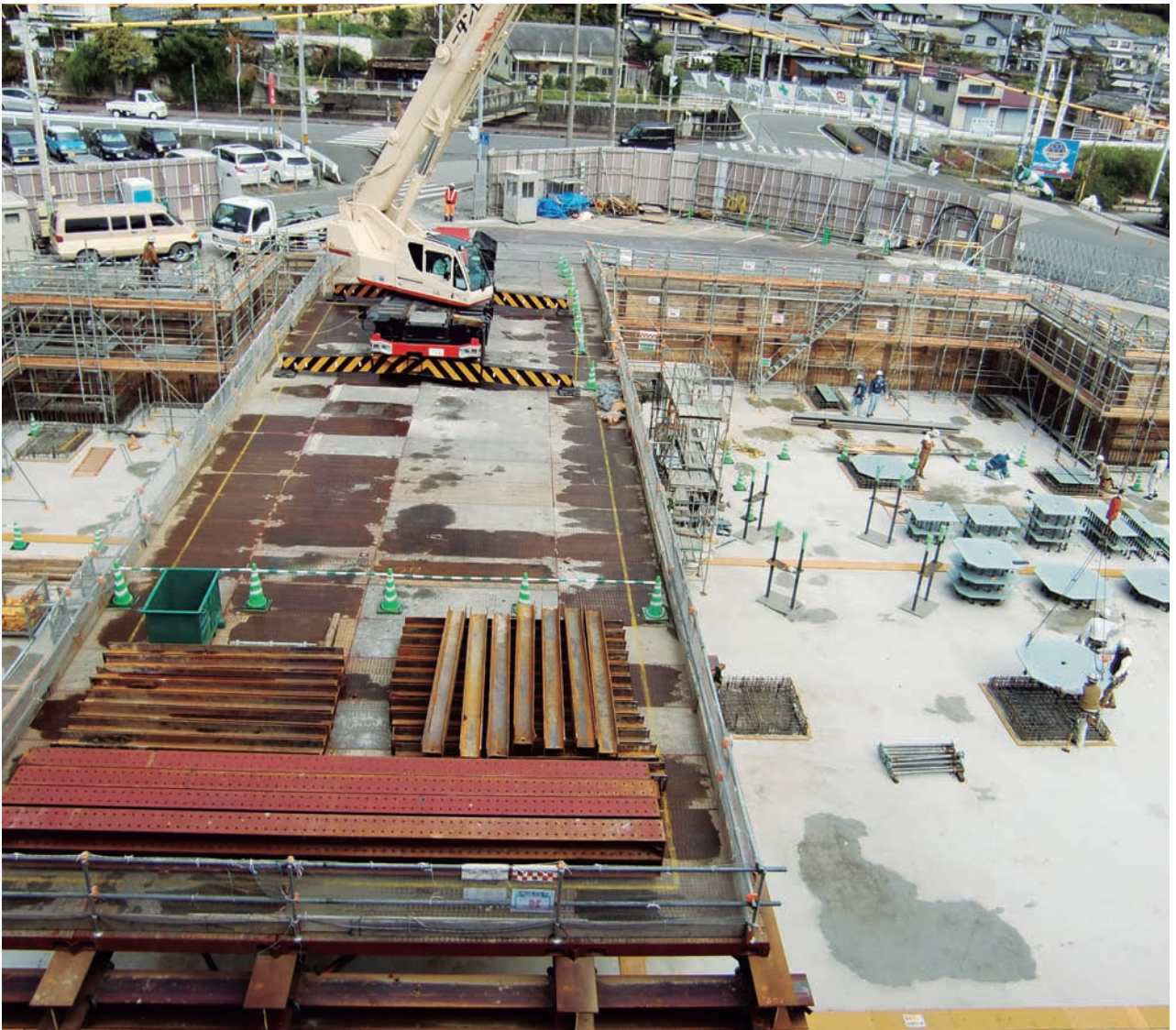
新庁舎建設工事（12月）
