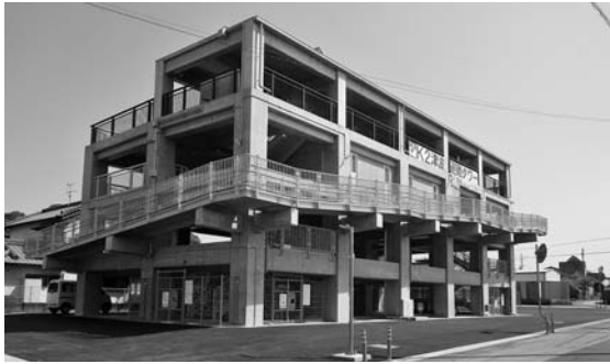
K 2 香我美町岸本10区津波避難タワー
