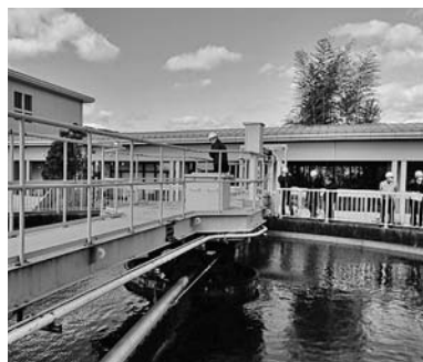
野市浄化センター
