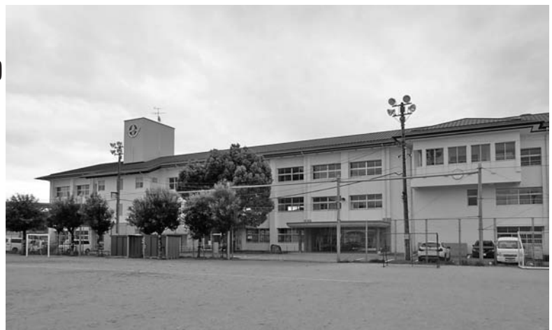
耐震化後の野市小学校
