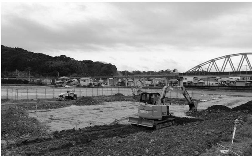
夜須町第6地区東部津波避難タワー建設予定地
