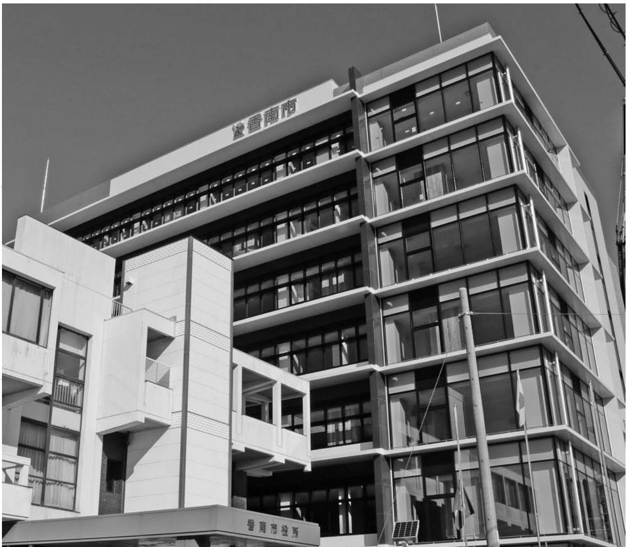
まもなく完成する香南市役所新庁舎（後方建物）
